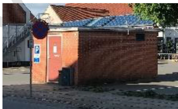
Billede af transformatorstationen på parkeringspladsen
