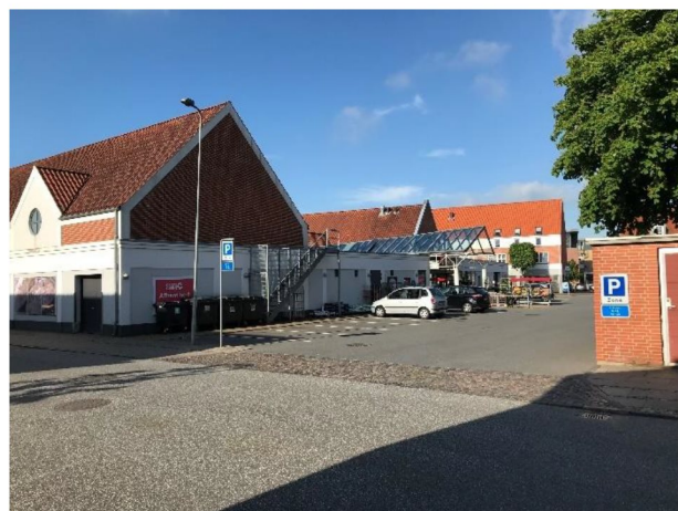
Billede af facade mod parkeringspladsen.
