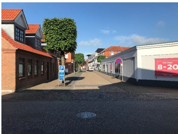
Billedet viser SuperBrugsens facade mod Jernbanegade
